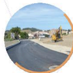
Début des opérations d'aménagement du quartier du Tissot (voirie et salle)
