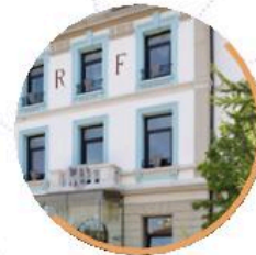
Réfection de l'accueil en mairie et rénovation de la salle du conseil municipal
