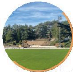
Démolition-reconstruction de la tribune-boulodrome
