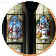
Restauration des vitraux de l'église et mise en place des grandes rosaces
